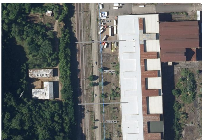
Foto gegen Fließrichtung
