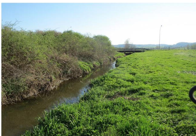
Foto gegen Fließrichtung
