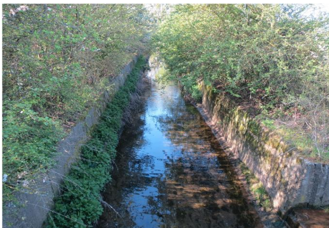
Foto gegen Fließrichtung
