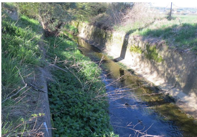
Foto gegen Fließrichtung
