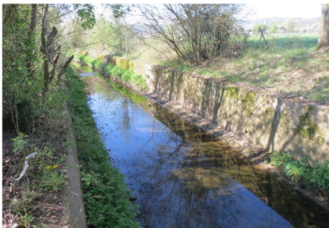
Foto gegen Fließrichtung
