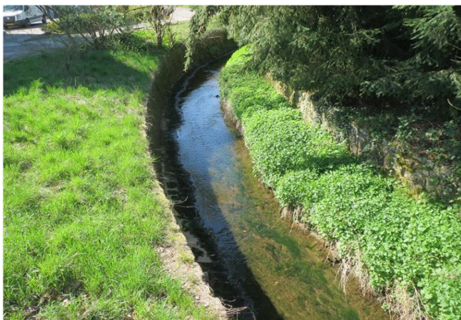
Foto gegen Fließrichtung
