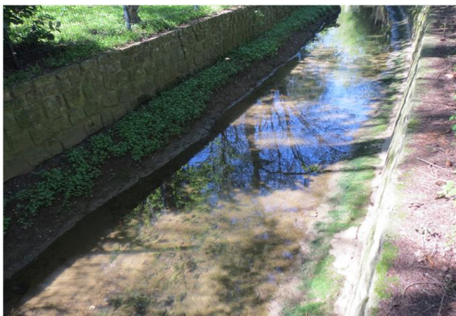
Foto gegen Fließrichtung
