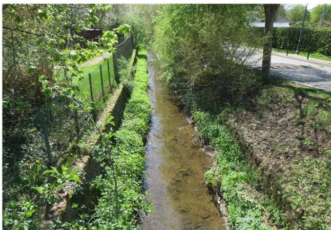
Foto gegen Fließrichtung
