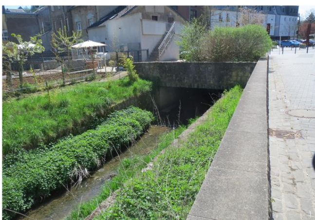
Foto gegen Fließrichtung
