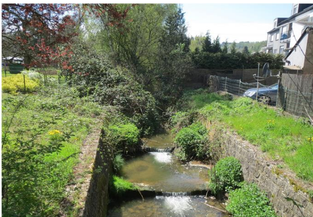
Foto gegen Fließrichtung
