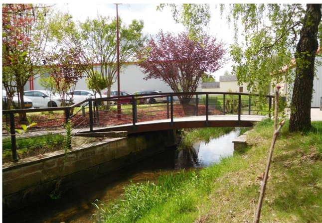
Foto gegen Fließrichtung
