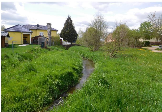
Foto gegen Fließrichtung
