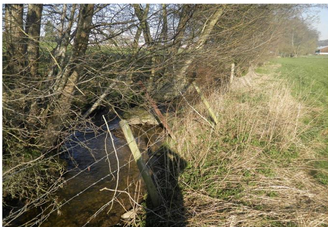
Foto gegen Fließrichtung
