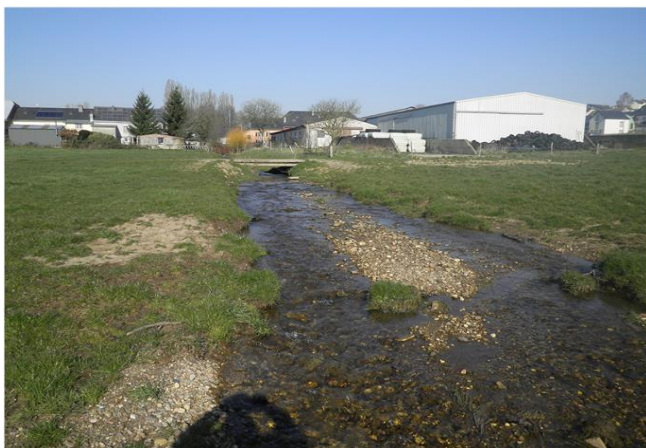
Foto gegen Fließrichtung
