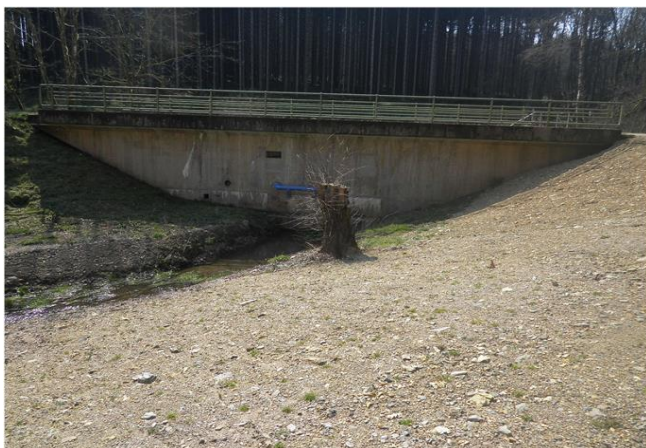
Foto gegen Fließrichtung
