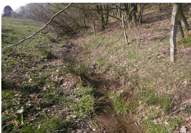
Foto gegen Fließrichtung
