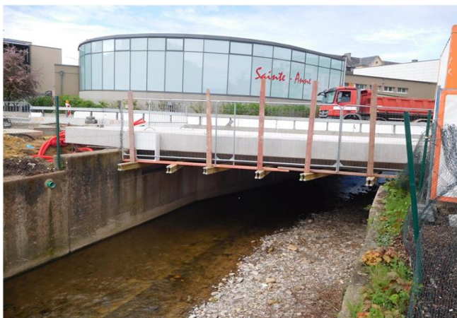
Foto gegen Fließrichtung
