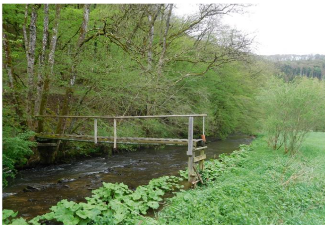
Foto gegen Fließrichtung
