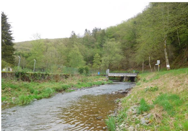
Foto gegen Fließrichtung
