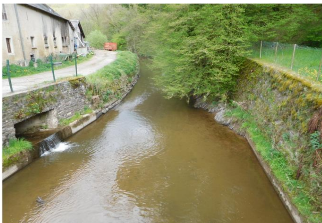
Foto gegen Fließrichtung
