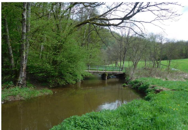
Foto gegen Fließrichtung
