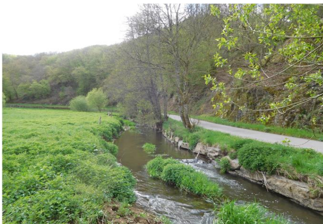
Foto gegen Fließrichtung
