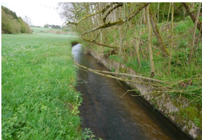
Foto gegen Fließrichtung
