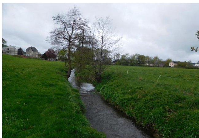
Foto gegen Fließrichtung
