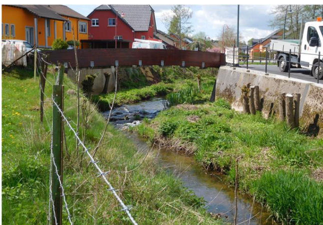
Foto gegen Fließrichtung
