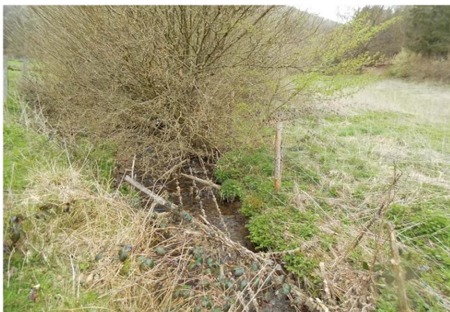
Foto gegen Fließrichtung
