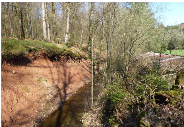
Foto gegen Fließrichtung
