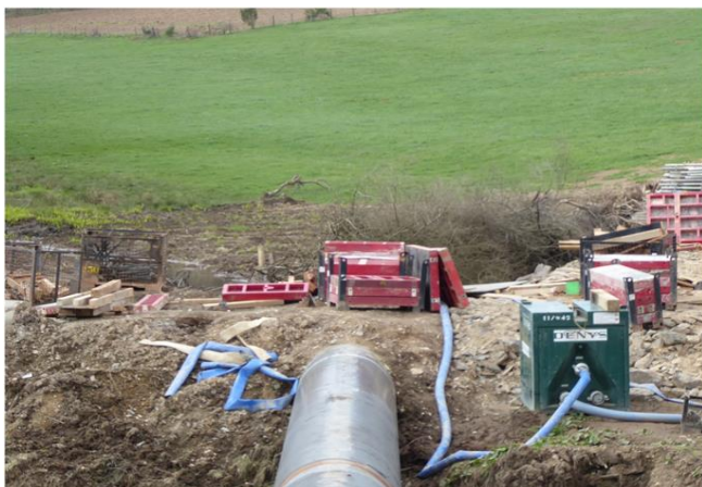
Foto gegen Fließrichtung
