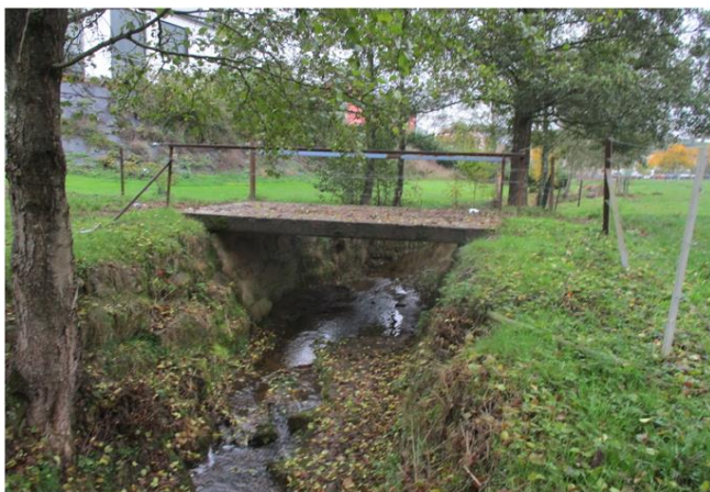
Foto gegen Fließrichtung
