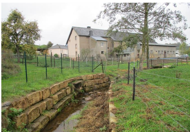
Foto gegen Fließrichtung
