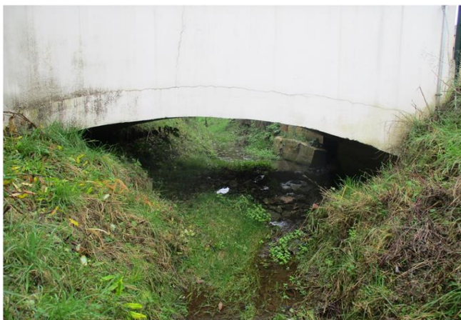
Foto gegen Fließrichtung
