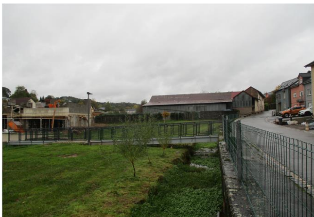
Foto gegen Fließrichtung
