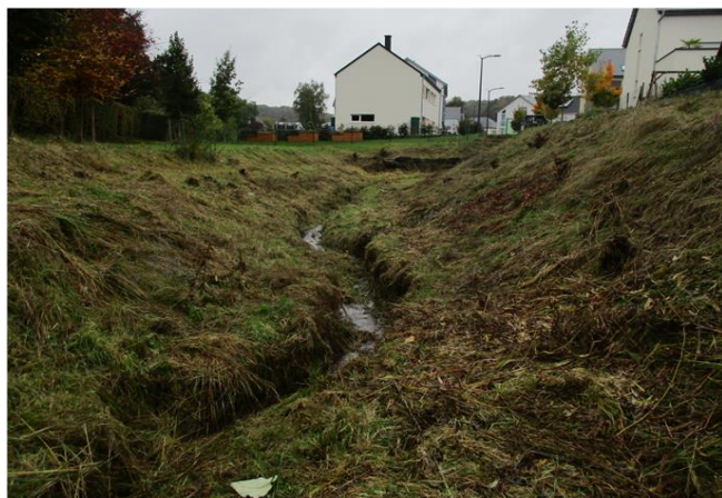
Foto gegen Fließrichtung
