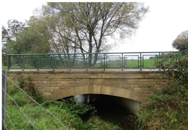
Foto gegen Fließrichtung
