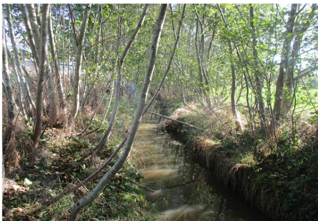
Foto gegen Fließrichtung
