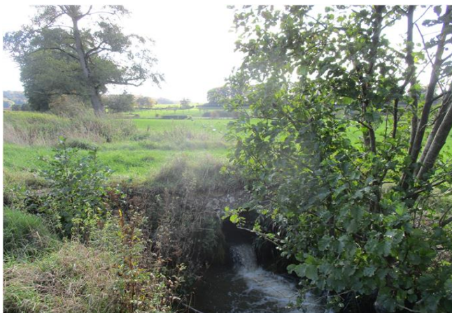
Foto gegen Fließrichtung
