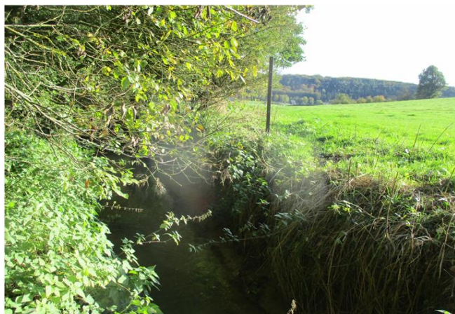
Foto gegen Fließrichtung
