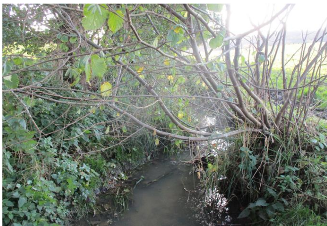
Foto gegen Fließrichtung
