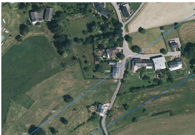
Foto gegen Fließrichtung
