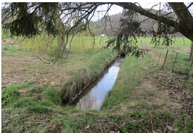
Foto gegen Fließrichtung
