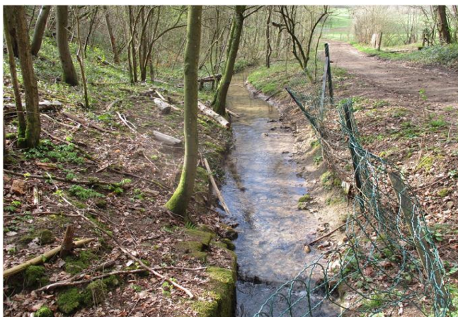
Foto gegen Fließrichtung
