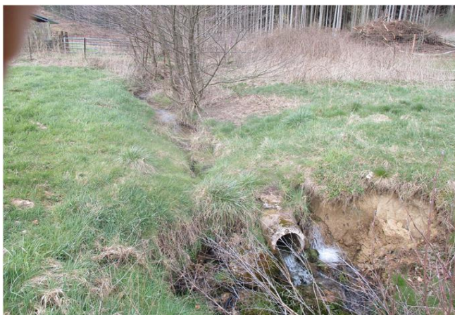
Foto gegen Fließrichtung
