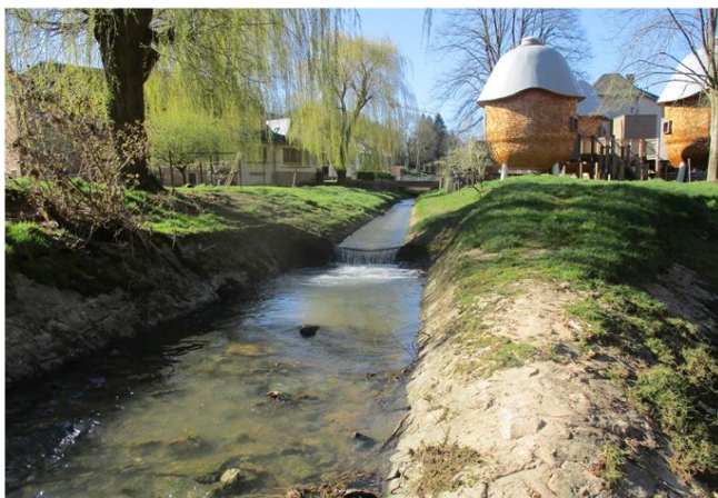
Foto gegen Fließrichtung
