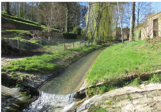
Foto gegen Fließrichtung
