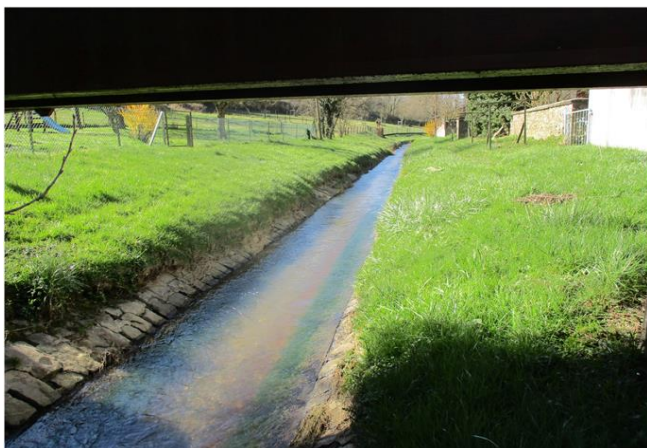
Foto gegen Fließrichtung
