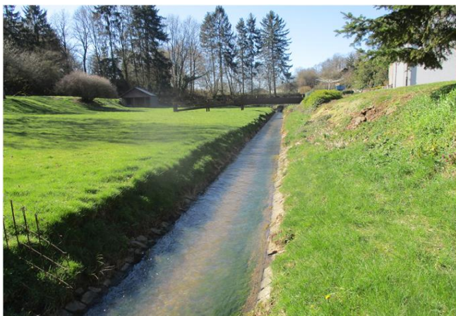
Foto gegen Fließrichtung
