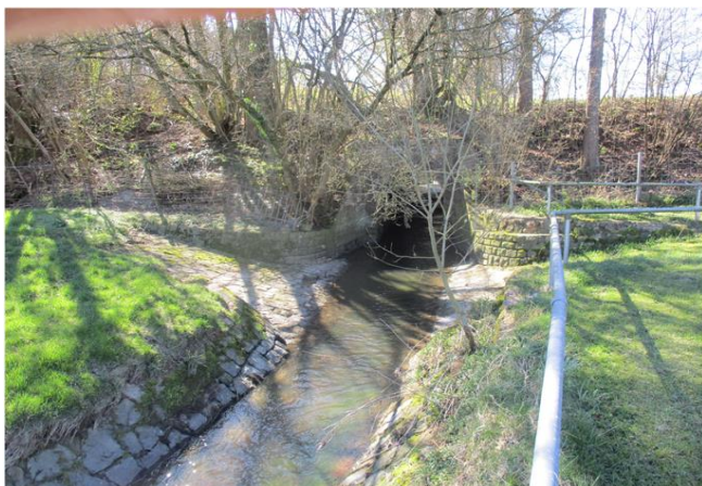
Foto gegen Fließrichtung
