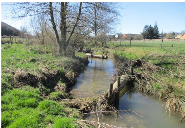
Foto gegen Fließrichtung
