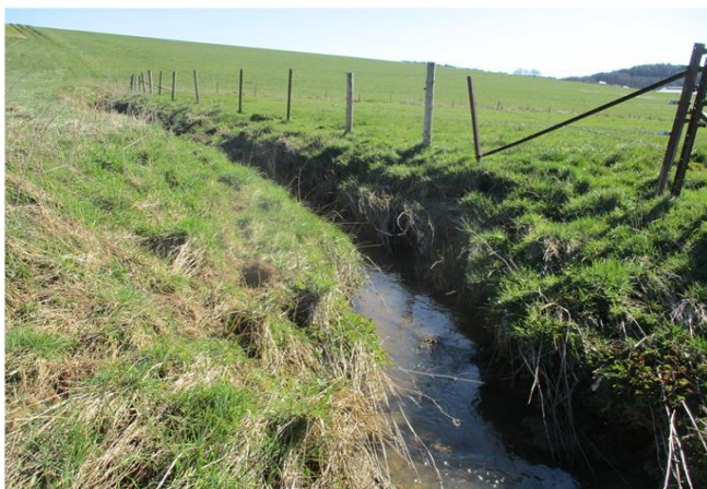
Foto gegen Fließrichtung
