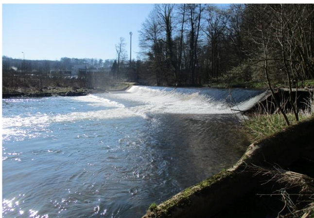
Foto gegen Fließrichtung
